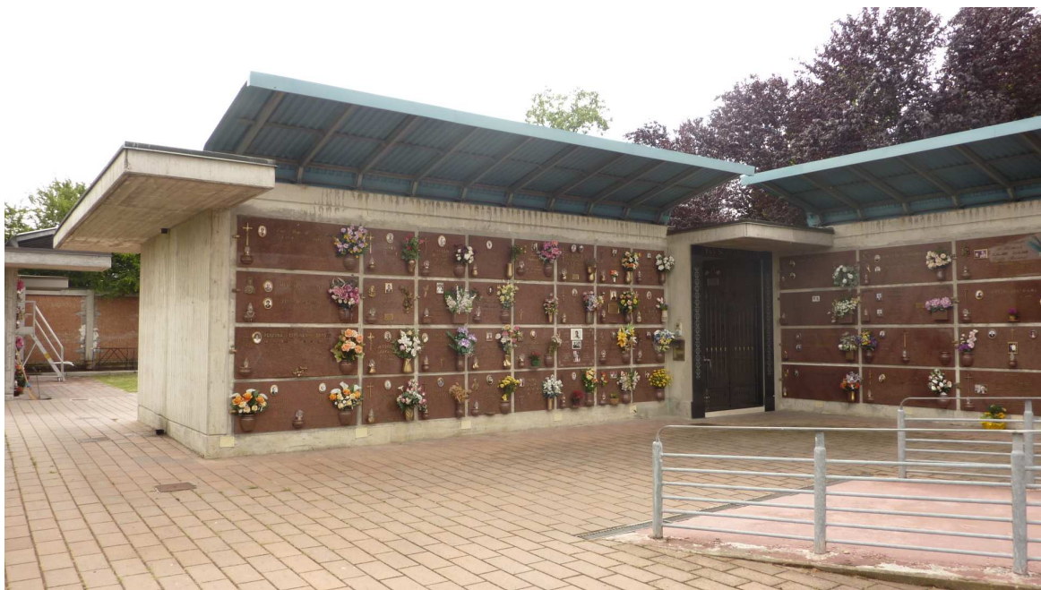
foto 2 – loculi esistenti, tipologia costruttiva di riferimento
