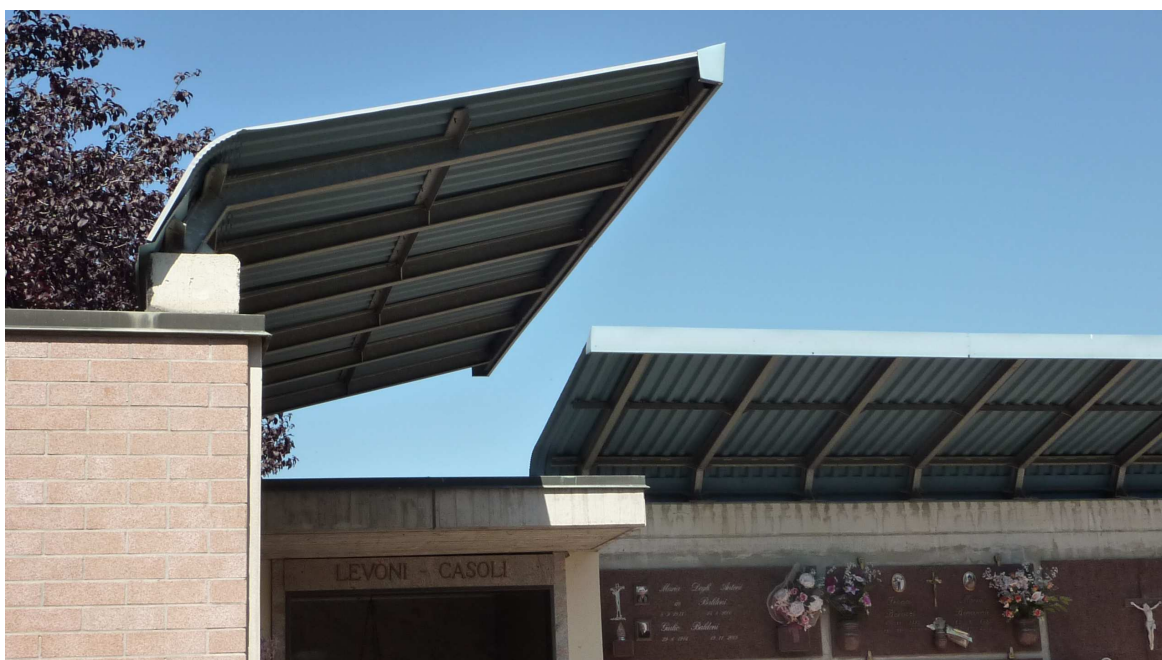
foto 3 – loculi esistenti, particolare pensilina metallica
